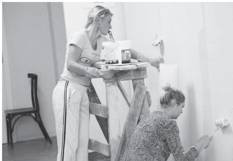
В будущем центре «Белая роза» завершается ремонт кабинетов
